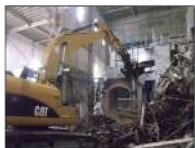
設備解体作業
