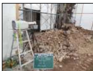
作業環境測定
