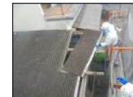
湿潤・手ばらしによる 屋根・壁材の撤去作業
