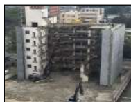
建物解体作業
