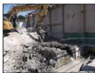
土間・基礎解体作業
