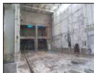
設備解体完了
