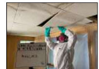
湿潤・手ばらしによる 内装材の撤去作業
