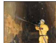
高圧洗浄による付着灰除去作業
