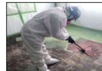
湿潤・手ばらしによる 床材の撤去作業
