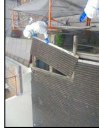
湿潤・手ばらしによる屋根・窓材の撤去作業
