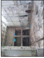
設備解体完了
