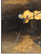
高圧洗浄による付着灰除去作業
